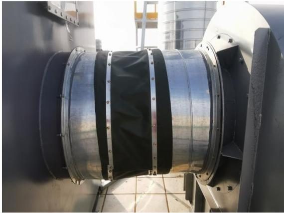
风机空气进出口采用软连接，以减少风管振动
